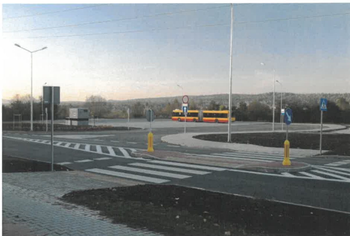
Rysunek 13 Pętla autobusowa przy ul. Sikorskiego
